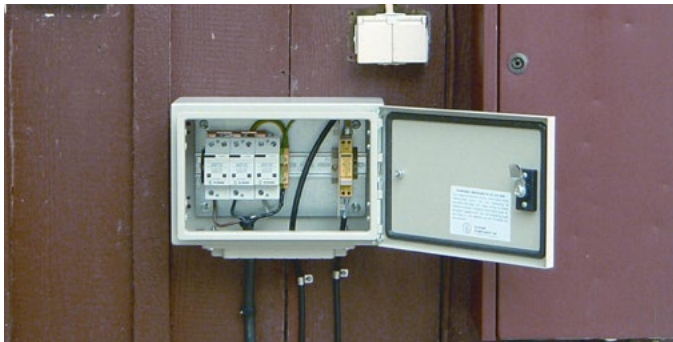
Exempel på inledningsskydd för el och tele.
