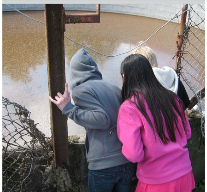
Det gäller att så långt som möjligt förebygga olycksfall. Om du har barn på gården ska verkstaden och andra farliga utrymmen alltid vara låsta. Trasiga skyddsnät som här på bilden får naturligtvis inte finnas.
