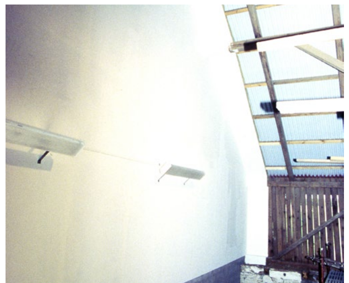
Här ser du ett bra exempel på hur en brandvägg kan se ut. Kontakta oss för råd och tips om hur du bygger brandväggar.
