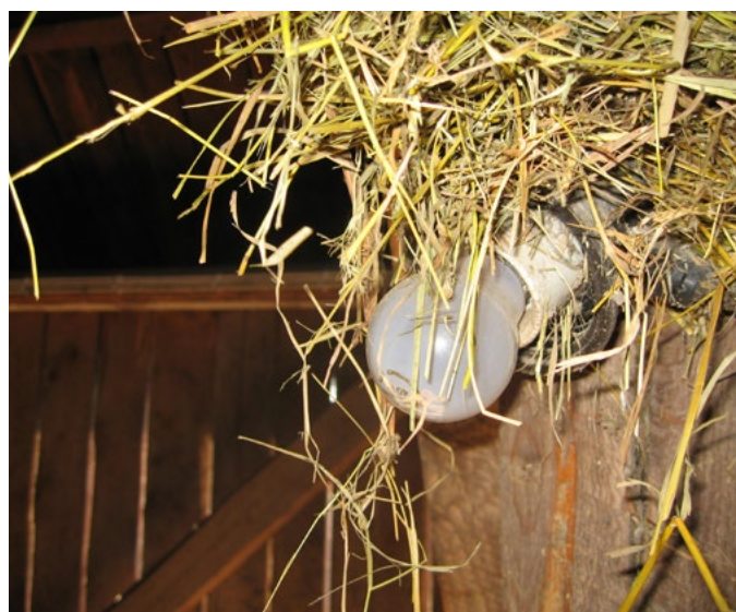
En glödlampa med trasig lampglob eller ingen alls kan lätt antända damm, hö eller halm. Se till att dina lampor alltid har hela och rena skyddsglas.
