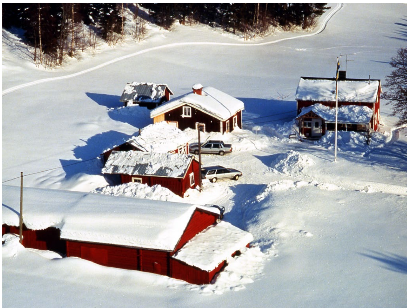
Varje vinter rasar många tak på grund av snötryck. Du måste skotta bort snön om du misstänker att taken kan rasa samman.
